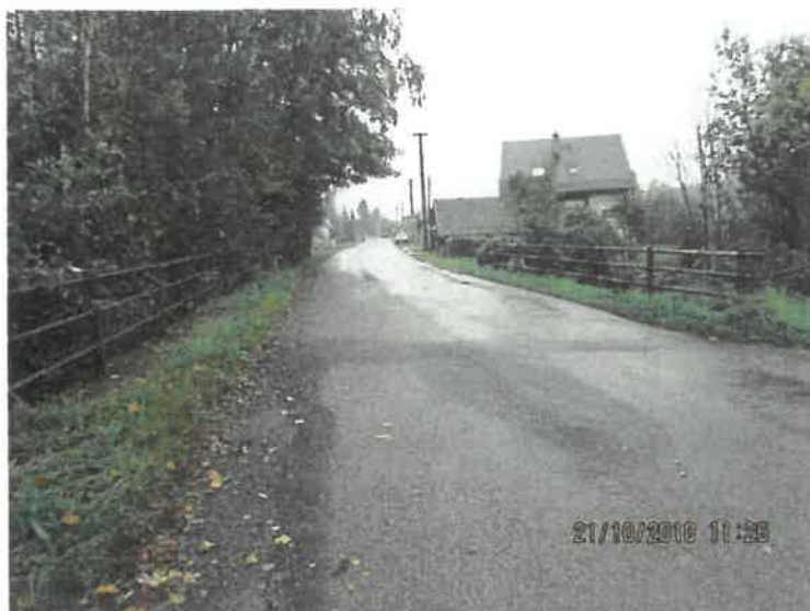
Pohled na most
