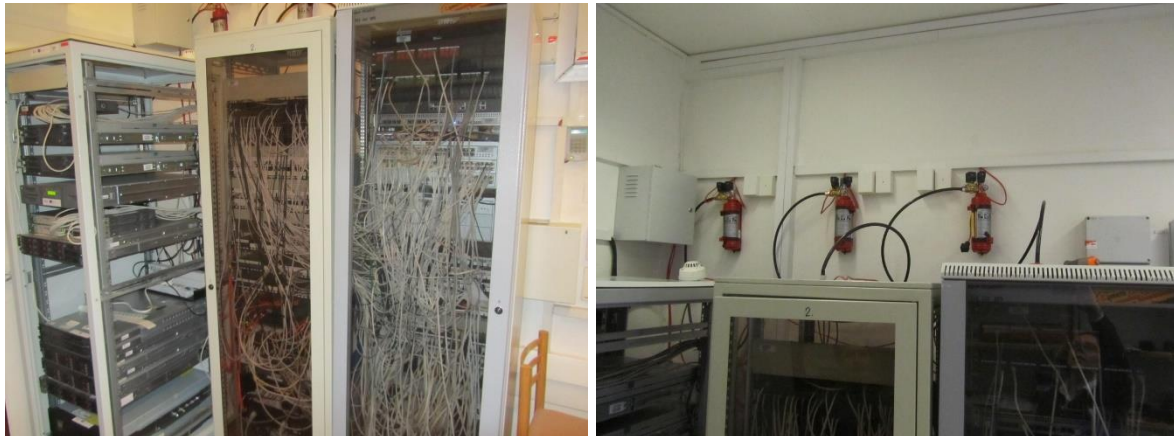
Obrázek 4: Serverovna a hasící systém
