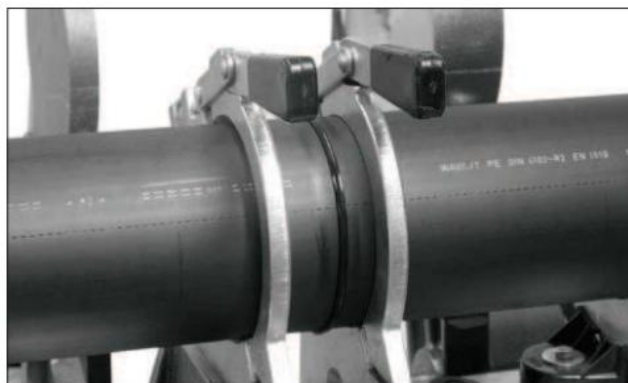
Chladnutí svařeného spoje
