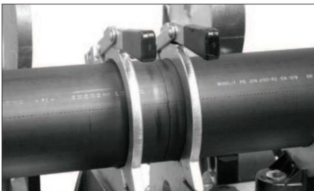
Správně připravené potrubí ke svařování
